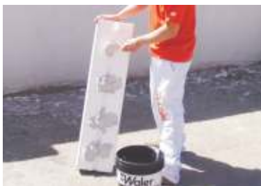
Applicazione con solo collante
