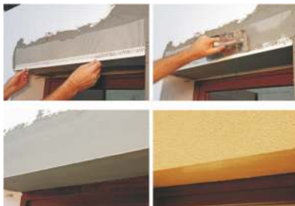
Dettaglio tecnico Raccordo cappotto su piano pilotis
