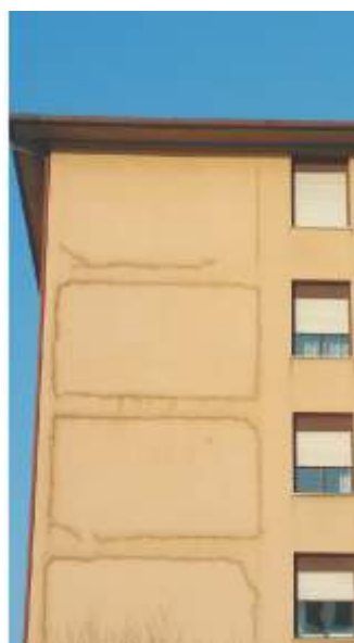
Degrado della facciata con ponti termici
