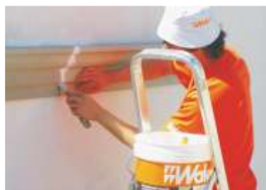
Applicazione con collante e profilo CW
