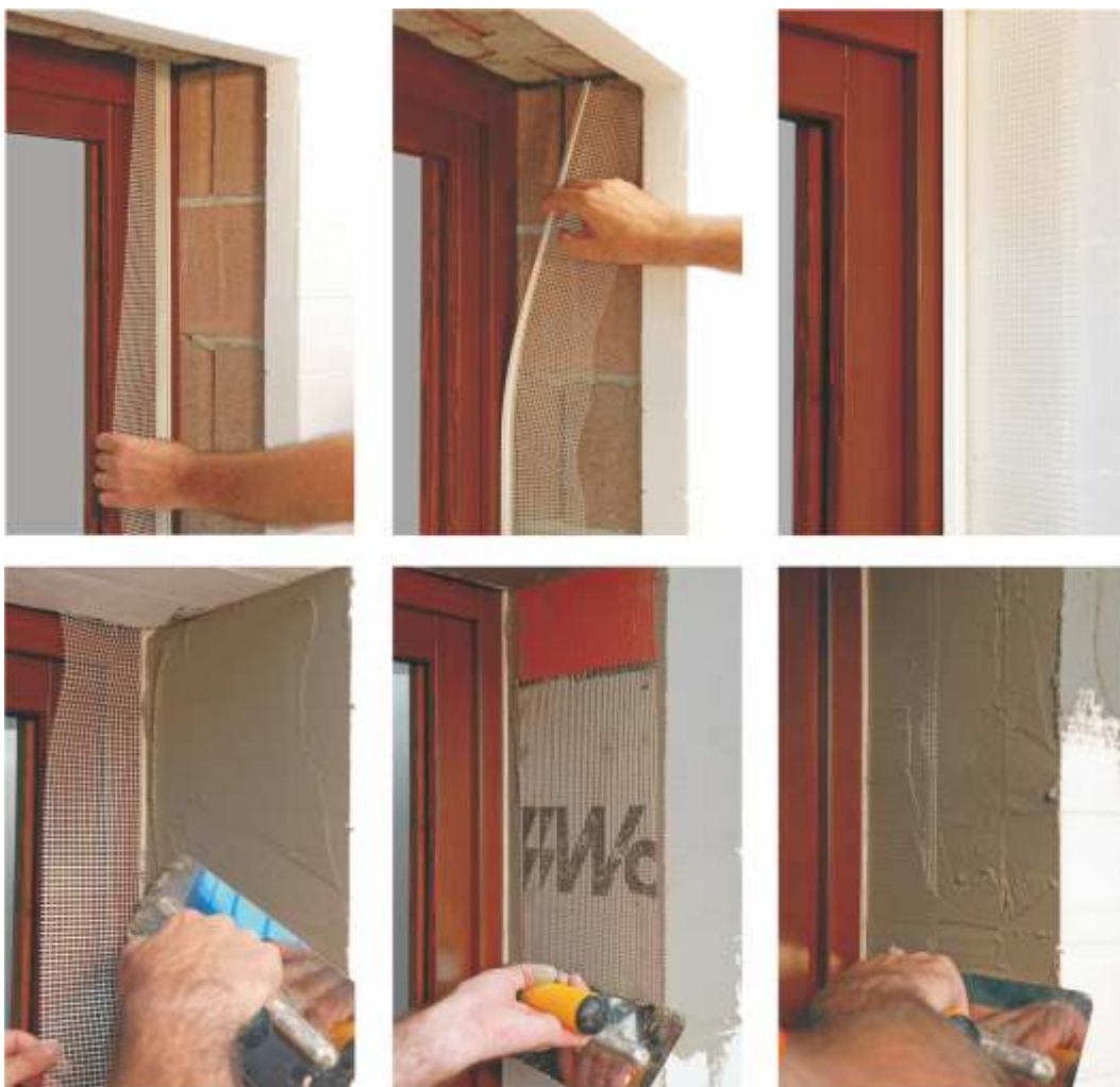
Dettaglio tecnico Cappotto su serramento a filo esterno
