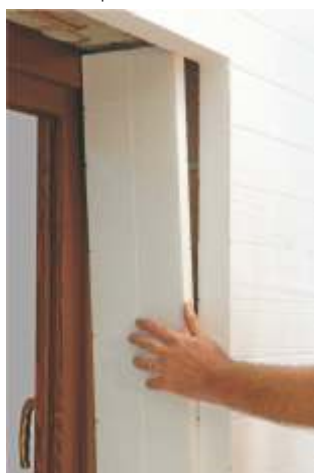
Esecuzione spallette finestra
